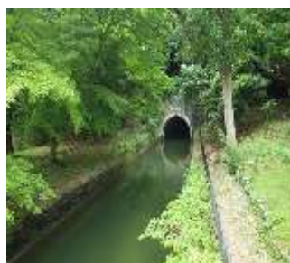
第3トンネル入り口
