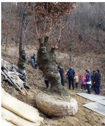
木の根と土が固まりとなった台場クヌギの根鉢を、菰で包んで根巻きする。 重量 2.5 トン。
