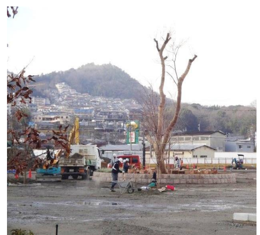
高さ：15m 重量：6 トンのエドヒガンを。工事中のキセラ川西せせらぎ公園へ移植。
