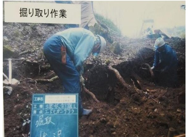
移植する2年前に必要な最小限の太い根を残し、それ以外は切除し、細根を発生させる掘り取り（根回し）作業を行なう。
